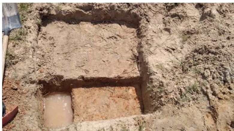
Foto 07: Ensaio de Capacidade de Absorção do Solo.
